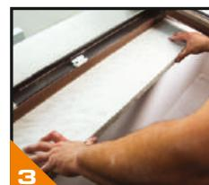
Montați glaful pe poziție. Este recomandat să lăsați o greutate pe glaf pentru a preveni extinderea în exces a adezivului.
