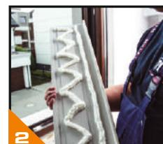
Odată ce adezivul spumă este aplicat cu pistolul, așteptați, între 60-120 secunde, un timp de reacție a spumei și abia apoi montați glaful pe poziție. Acest timp de reacție a spumei este necesar pentru a scurta timpul de priză.
